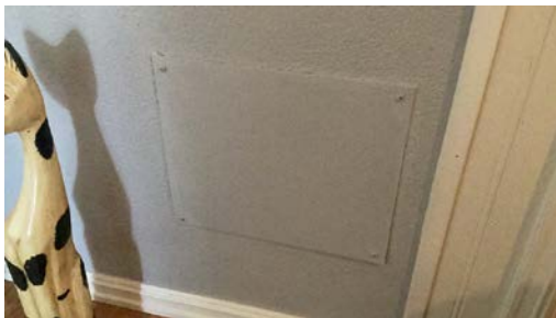
Sotluke i gang.
