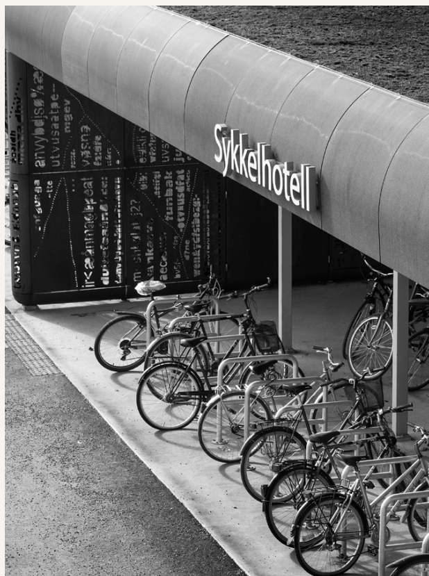
Sikker og praktisk sykkelparkering. Det nye parkeringsanlegget i As har totalt 2818 parkeringsplasser for sykkel, hvorav 208 er i hodelett samt plass til store lastesykler. De øvrige 180 er ute under tak. Alle kan kjøpe tilgang til sykkelhotellet med appen Bane NOR Parkering.
