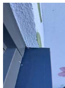
Vannbrettbeslag under vinduer.
