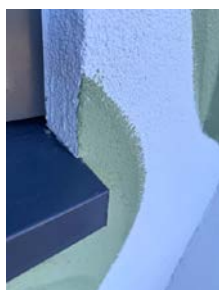
Vannbrettbeslag under vinduer.
