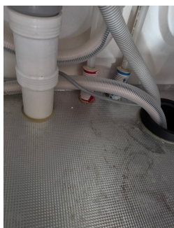
Varerørene på kjøkkenet er tettet fagmessig
