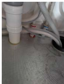
Varerørene på kjøkkenet er tettet fagmessig
