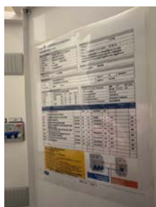
Kursbetegnelse til fordelerskap/sikringskap
