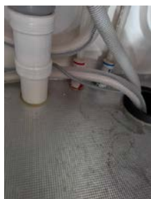
Varerørene på kjøkkenet er tettset fagmessig
