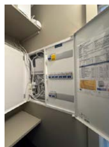
Fordelerskapet/sikringskapet i boden.
