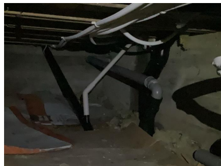
Bilde tatt i fra åpning mot krypkjeller.
