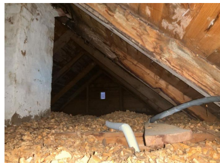
Isolert loft med treflis.
