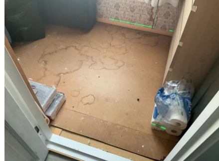
Bod på loftetasje er har gamle overflater, og ingen gulv over huntonittplater.
