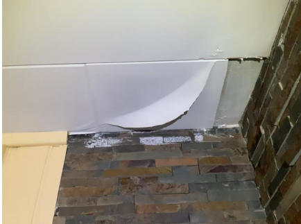
Avvik på overflate himling stue ved pipe. Belegg på himlingsplate er løsnet.
