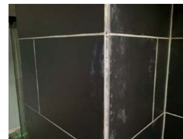
Bom bak fliser på pipe loftetasje.
