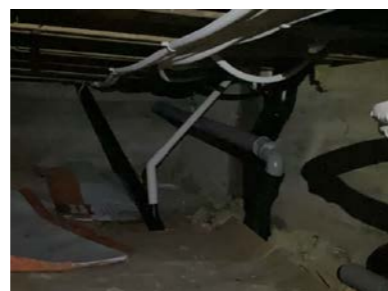
Bilde tatt i fra åpning mot krypkjeller.
