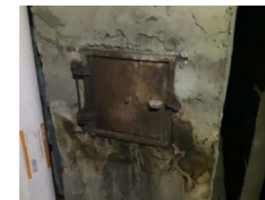
Det er rustskader på sotluke i kjeller.
