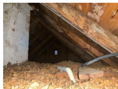
Isolert loft med treflis.
