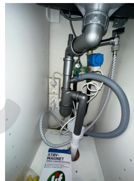
Rørpropp i kjøkkenbenk med Waterguard
