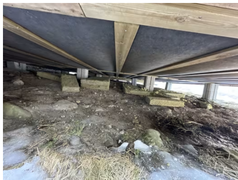
Tilbygg med åpen fundamentering.
