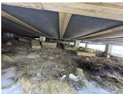
Tilbygg med åpen fundamentering.
