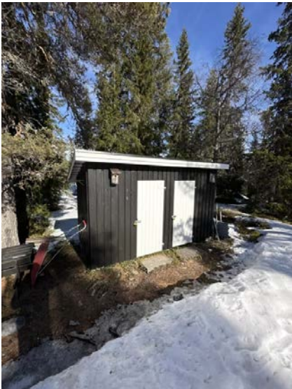
Viser frittstående uthus med bod og utedo/bod.
