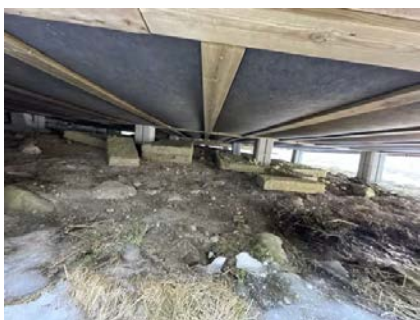
Tilbygg med åpen fundamentering.
