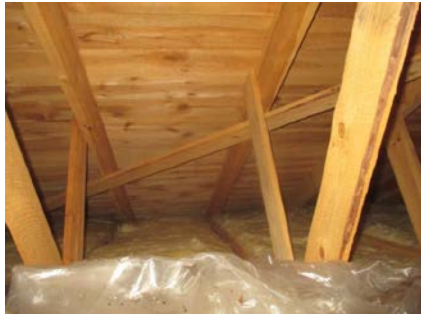
Plassbygget takstoler med bord som undertak.
