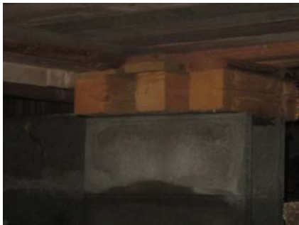
Hytta har blitt jekket opp en del på grunn av sig i pilarer.
