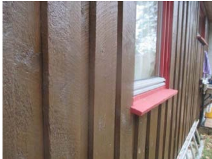
Deler av kledningen med tilhørende belistninger.
