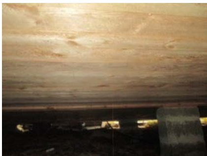
Deler av underliggende stubbloft.
