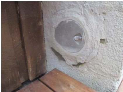
Nær brennbart materiale.
