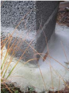
Er nylig blitt gravd i rundt og støpt på nytt rund pilarer.
