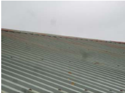
Deler av taktekkingen.
