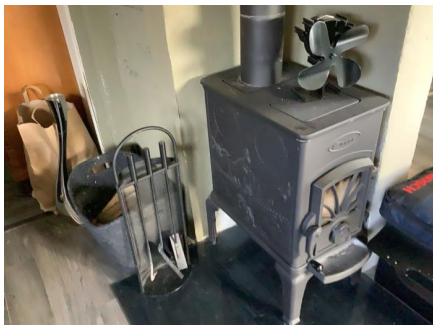
Vedovn har kort avstand til brannmur.
