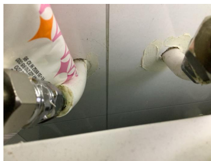
Ufagmessig utførelse rundt gjennomføringer og avslutning av våtromsplater mot gulv.
