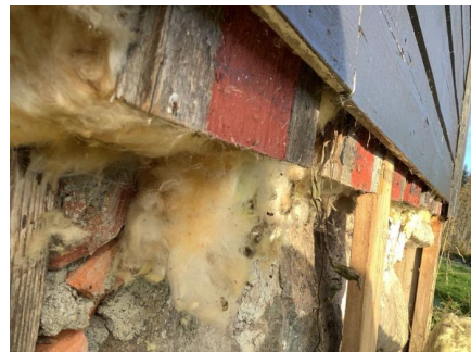
Liggende panel er festet på eldre stående panel.
