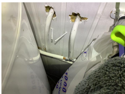
Eldre skrukobliger og kobberør.
