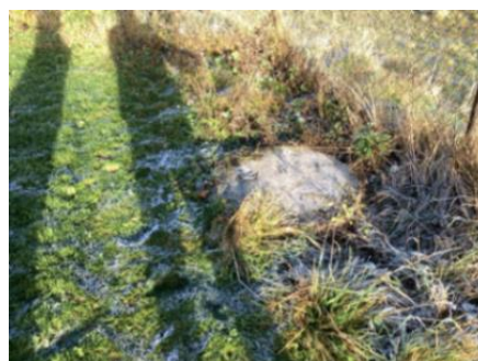
Opplyst sementkum for kloakk. Ikke undersøkt tilstand.
