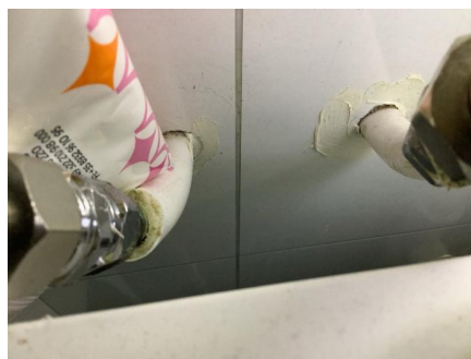
Ufagmessig utførelse rundt gjennomføringer og avslutning av våtromsplater mot gulv. Utette rørgjennomføringer i vegg.
