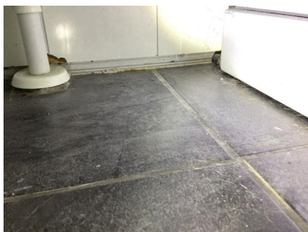
Ufagmessig utførelse rundt gjennomføringer og avslutning av våtromsplater mot gulv. Utette rørgjennomføringer i vegg.
