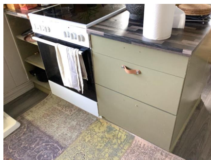
Manglende håndtak på deler av innredning.
