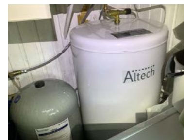
Strømtilførsel er via stikkontakt. dagens krav skal være direktekobling av bereder via bryter. Se "El-opplegg"
