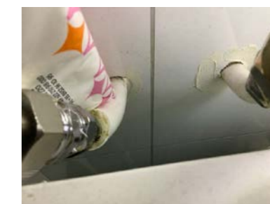
Ufagmessig utførelse rundt gjennomføringer og avslutning av utette rørgjennomføringer i vegg. våtromsplater mot gulv.
