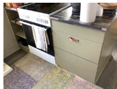
Manglende håndtak på deler av innredning.
