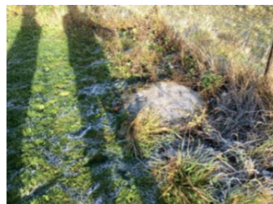
Opplyst sementkum for kloakk. Ikke undersøkt tilstand.
