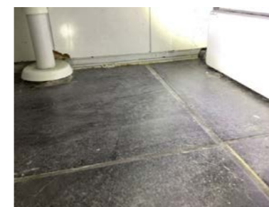
Ufagmessig utførelse rundt gjennomføringer og avslutning av utette rørgjennomføringer i vegg. våtromsplater mot gulv.
