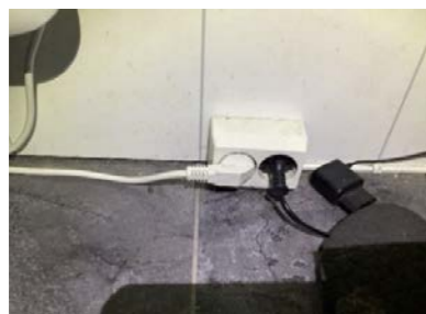
Ufagmessig el-opplegg mot gulv i våtrom.
