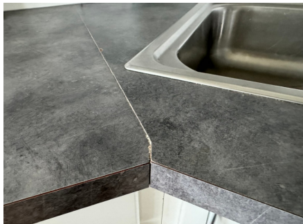
svelling i benkeplate.
