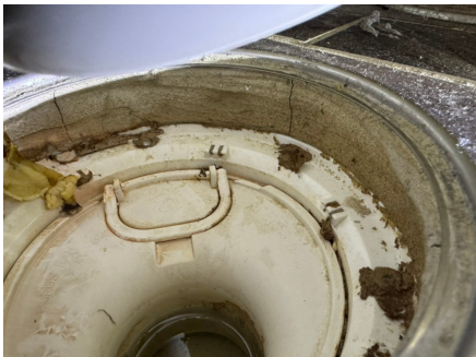
Sprekk i avrettingsmasse.
