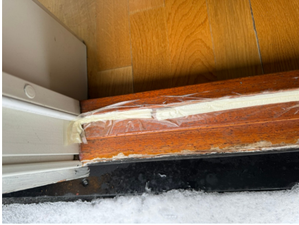
Tetting under altandør.
