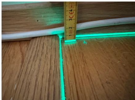
Måling ved ytterveggen.
