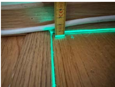
Måling ved ytterveggen.
