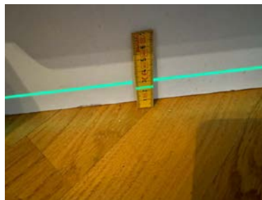
Måling ved kjøkkeninnredningen.
