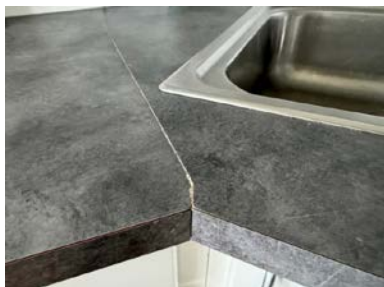
svelling i benkeplate.
