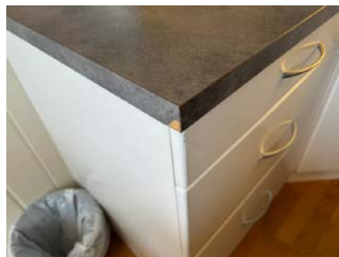
Skade på benkeplate.
