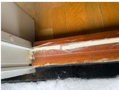
Tetting under altandør.
