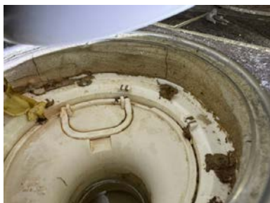
Sprekk i avrettingsmasse.
