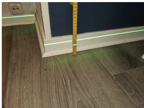
Etasjeskillet er kontrollert med nivelleringslaser.
