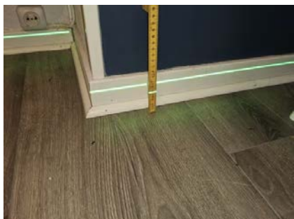
Etasjeskillet er kontrollert med nivelleringslaser.
