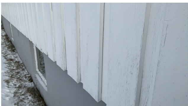
Råteskader i bunn av kledningen mot vannbrett da denne er montert for tett i mot vannbrettet.
