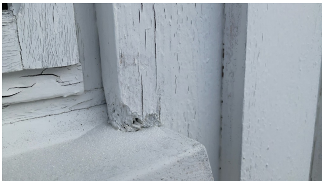
Råteskader i bunn av kledningen mot vannbrett da denne er montert for tett i mot vannbrettet.
