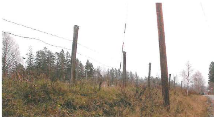
Rester etter gjerdet langs toglinja nord for Skulerud stasjon.
