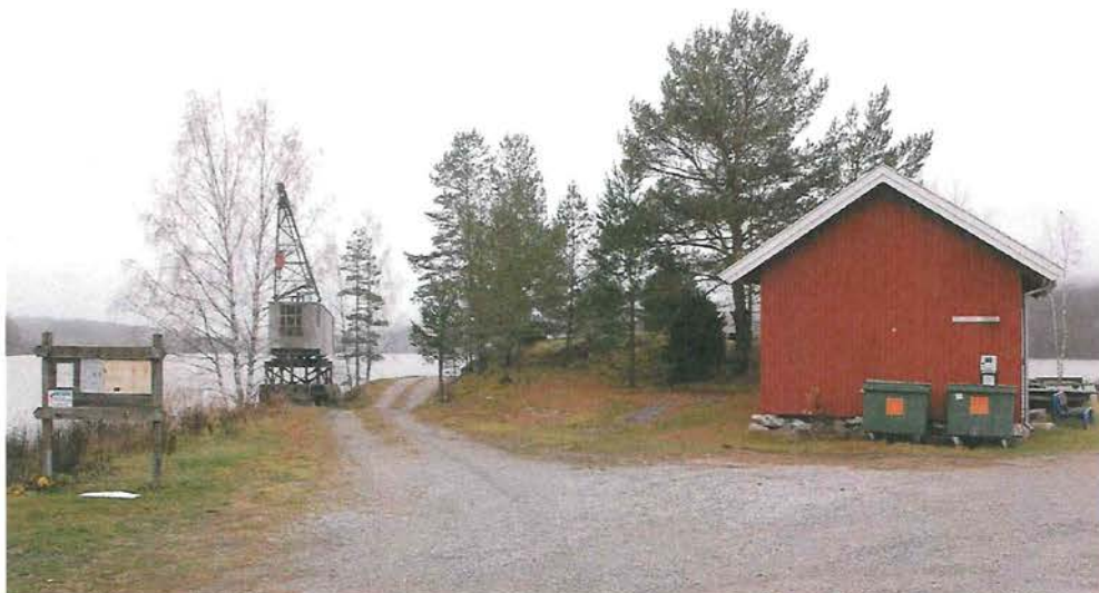
Bildet over viser krana og pakkehuset på Skulerud brygge.
