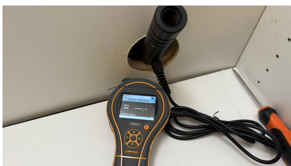
Fuktmåling i vegg mot dusjen
