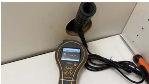
Fuktmåling i vegg mot dusjen
