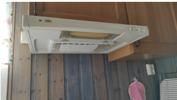
Funksjonstest av avtrekk.
