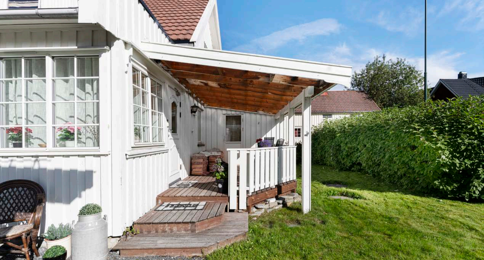
Inngang til utleiedel - Nye vinduer i entrè
