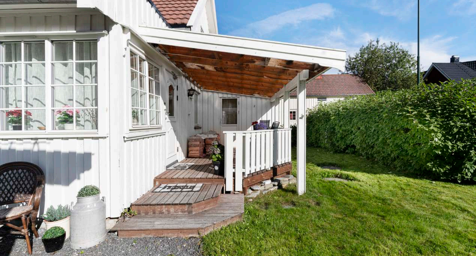
Inngang til utleiedel - Nye vinduer i entrè
