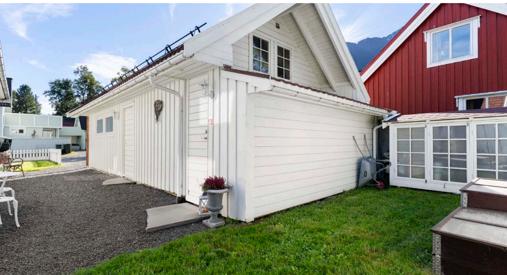
Garasje sett fra terrasse i hoveddel- redskapsbod til høyre - inngang til vedbod i bakre del av garasje
