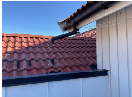
Takvann fra nabo som føres ned i boligens nedløp
