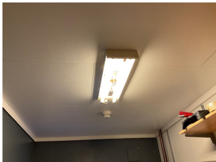
Armatur mangler skjerm
