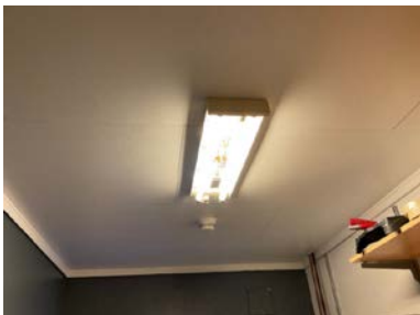
Armatur mangler skjerm
