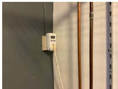
Støpsel til VV bereder
