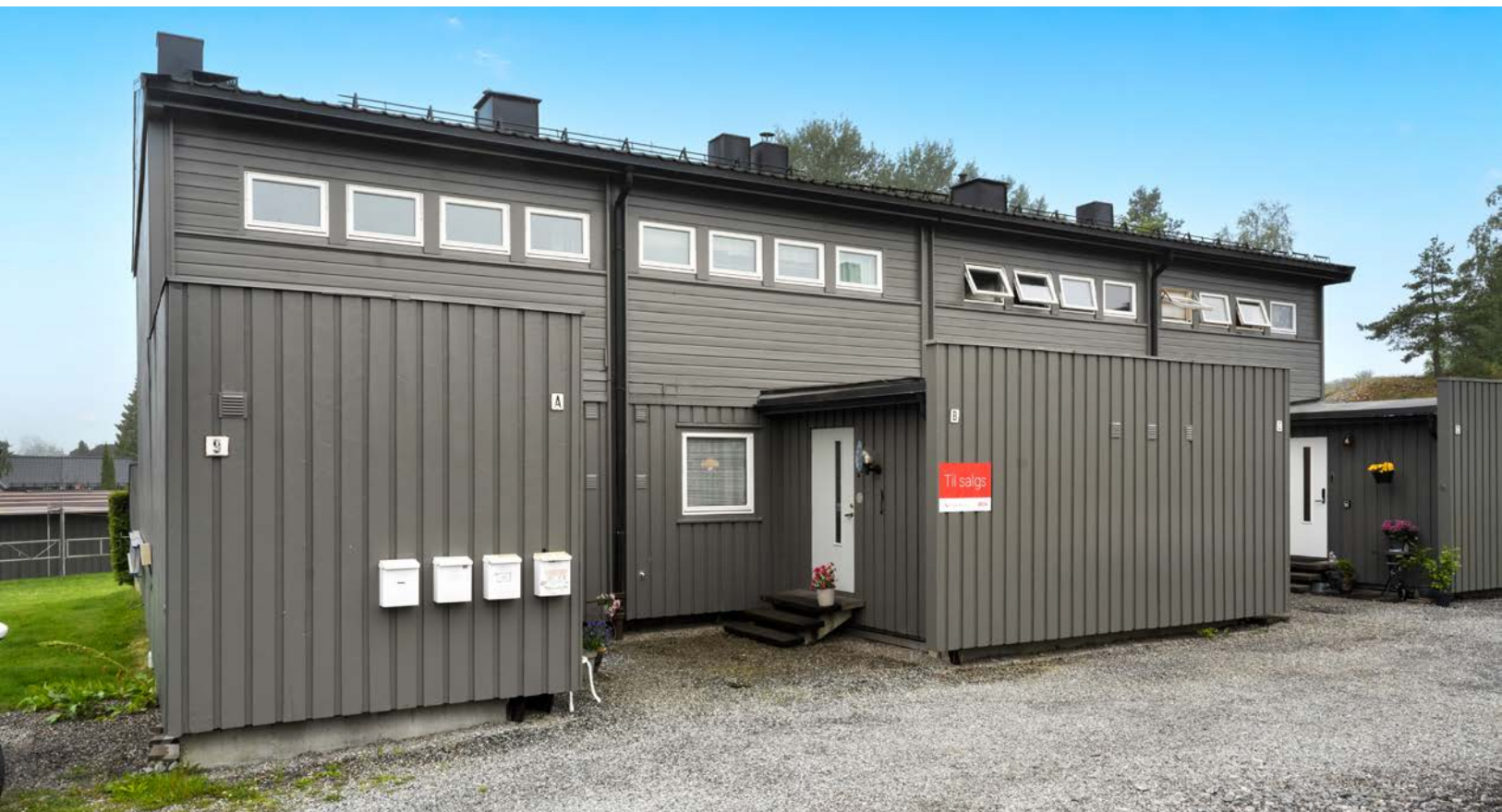
Rekkehus over 2 etasjer med gruset adkomst
