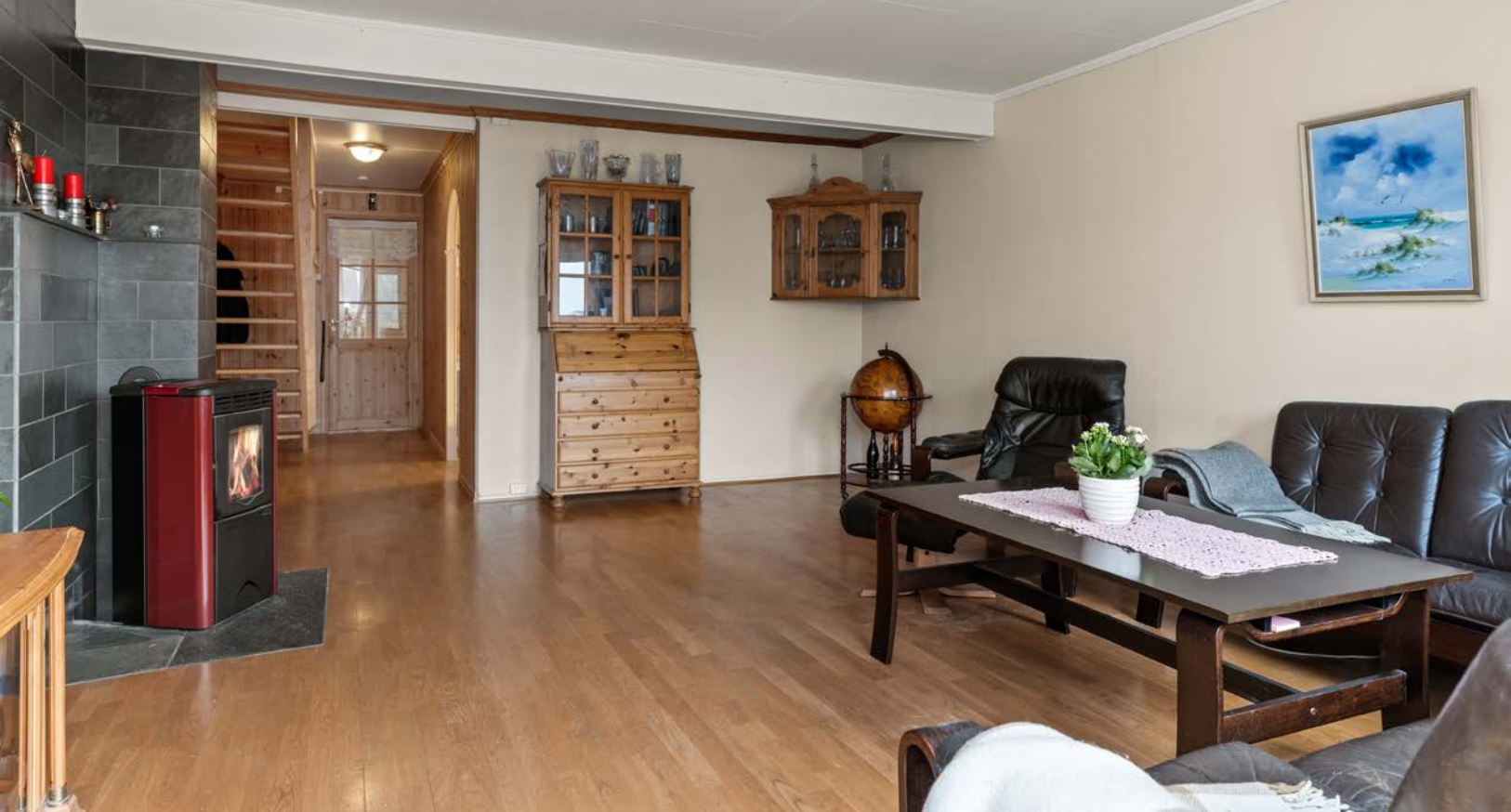
Boligen har pelletsovn i stuen, samt luft/luft varmepumpe.
