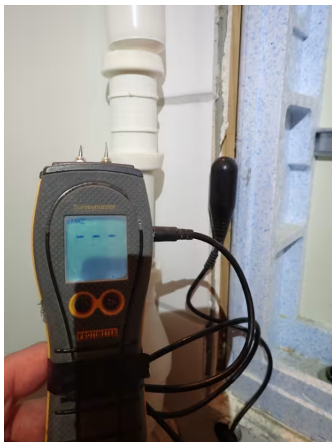
Fuktmåling i treverk i vegg ved rørskap viser ingen tegn til fukt i konstruksjonen.
