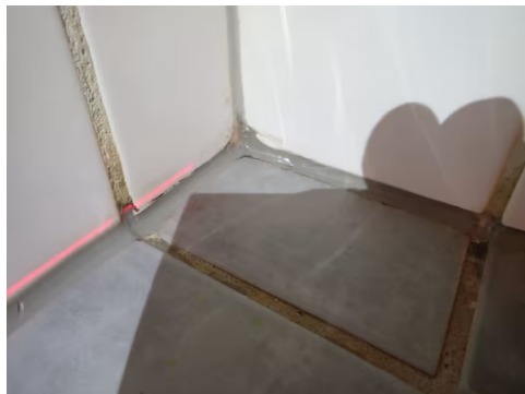
Utført etterfuging i dusjhjørnet, misfarging i eldre fuger.
