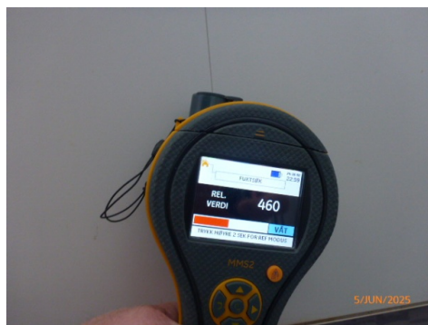
446, plateskjøt på vegg noe opp på plater inne i dusjnisen
