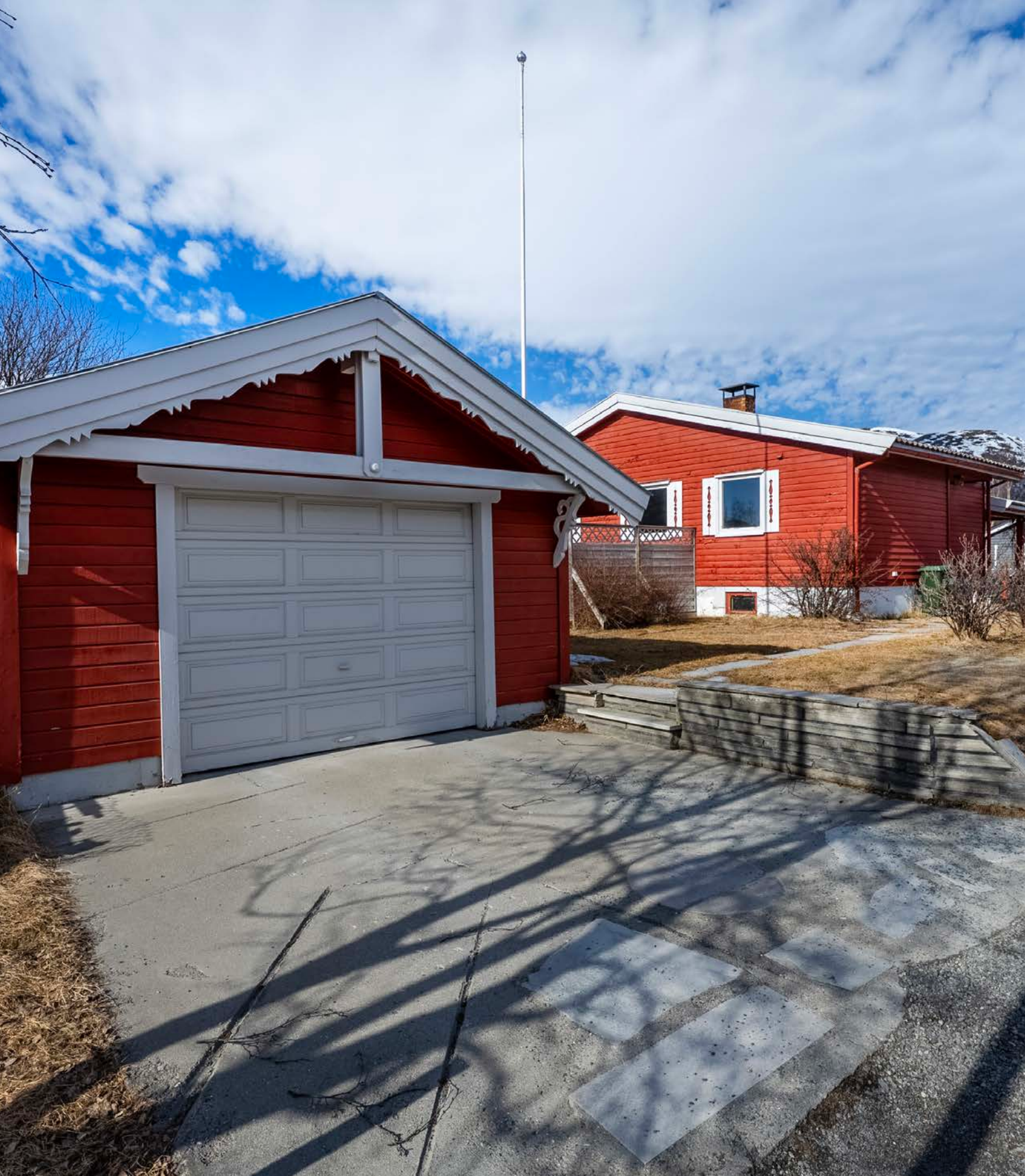
Frittstående garasje oppført i 1997
