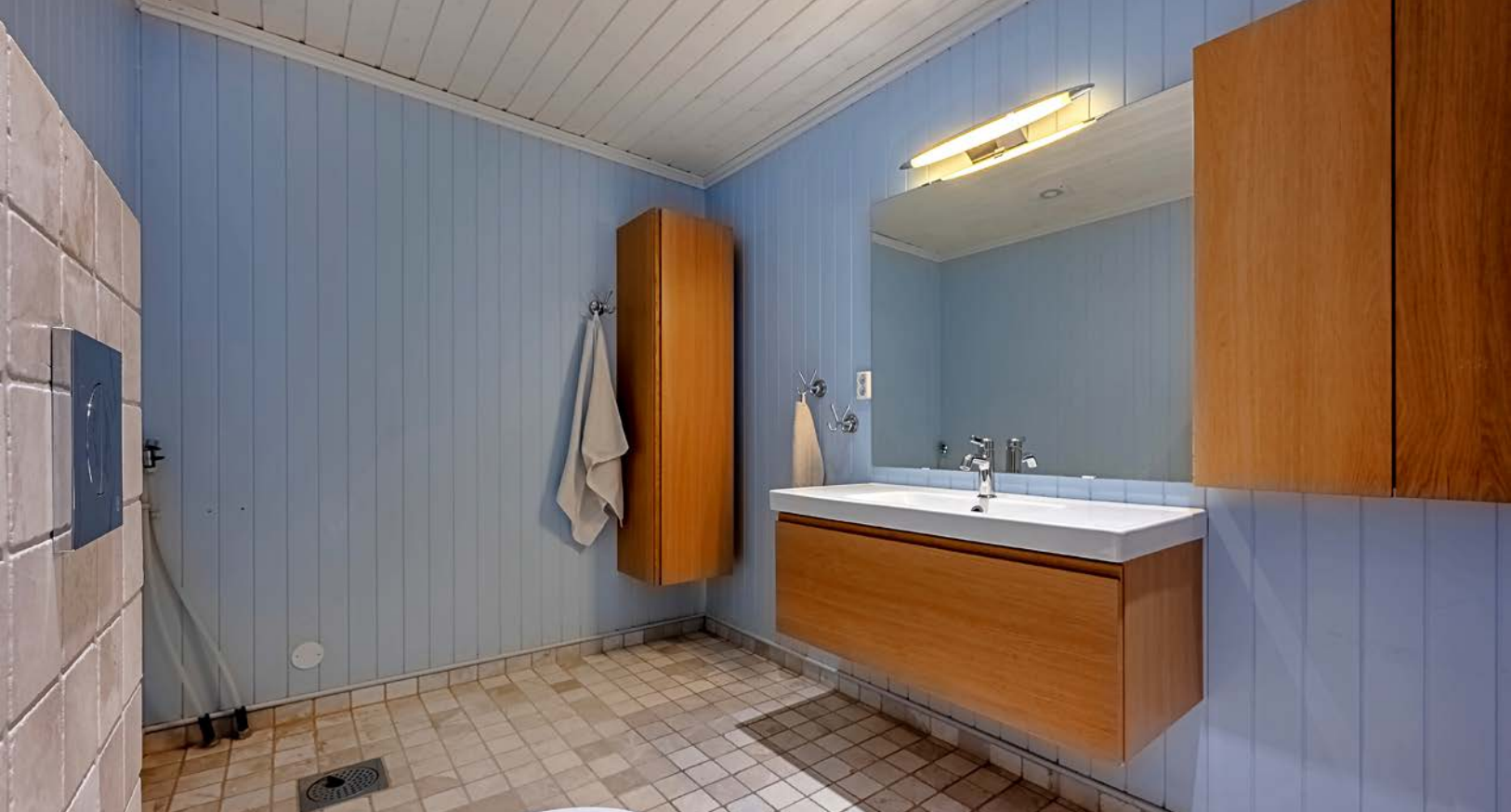
Badet er klargjort for montering av dusjkabinett
