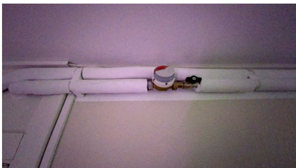
Stoppekran i entre bør merkes.
