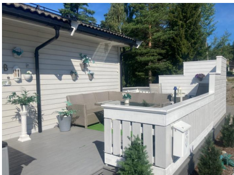
Terrasse ved inngangsparti.
