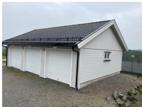
Garasje plass til høyre disponeres av leiligheten.
