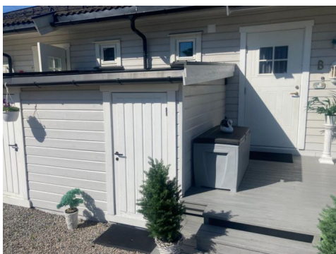
Bod ved inngangsparti.
