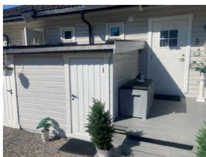
Bod ved inngangsparti.
