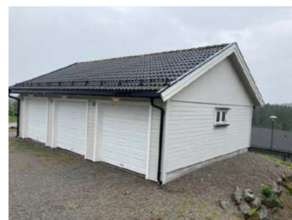
Garasje plass til høyre disponeres av leiligheten.
