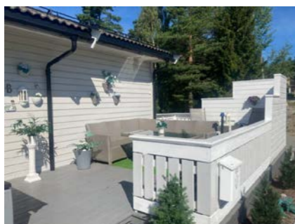
Terrasse ved inngangsparti.
