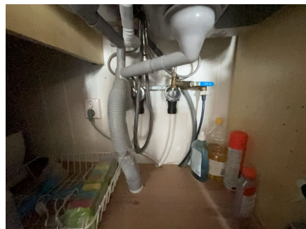
Del av rør til vann.
