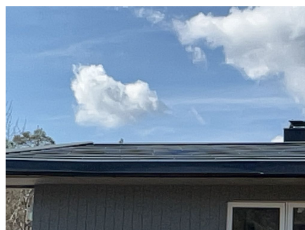
Del av taktekkning.
