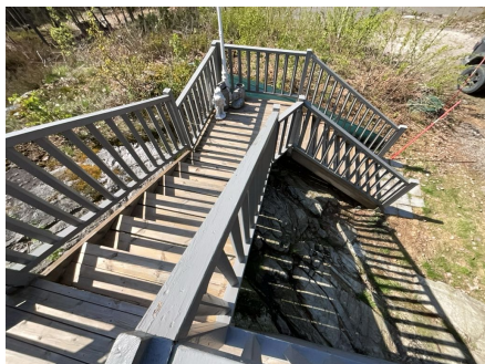
Trapp ned fra terrasse.
