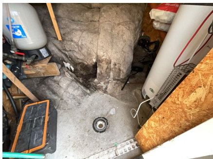
Del av rom under terreng.
