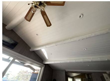
Del av takkonstruksjon.
