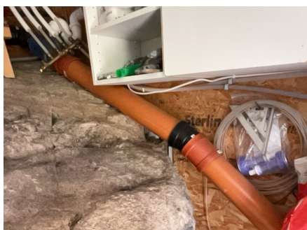
Del av rør til avløp.
