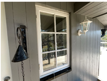
Eksempel på vindu i yttervegg. Eldre dato.
