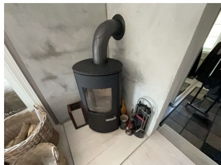
Montert ovn i stue.
