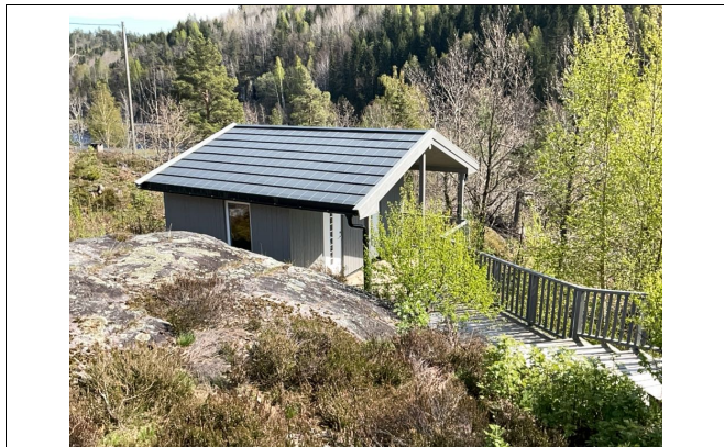
Uthus oppført på eiendommen.
