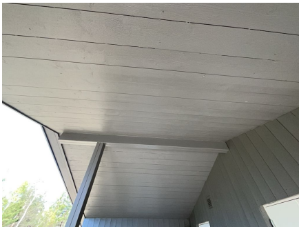
Del av takkonstruksjon.
