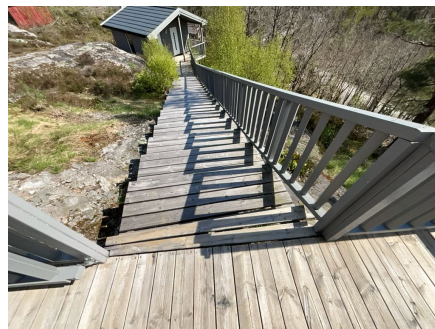
Trapp ned fra terrasse.
