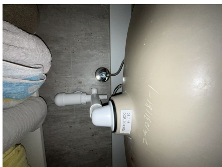
Del av rør til avløp.
