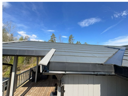
Del av taktekkning.
