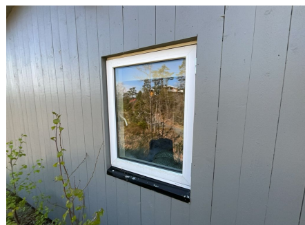
Eksempel på vindu i yttervegg.
