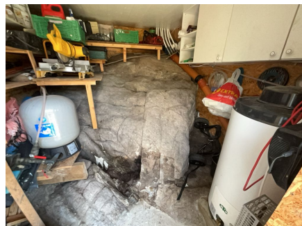
Del av rom under terreng.
