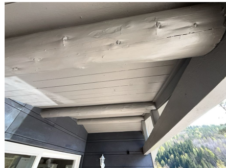
Del av takkonstruksjon.
