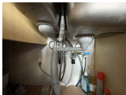
Del av rør til avløp.
