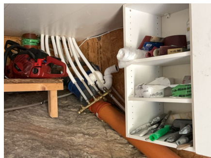
Del av rør til vann.
