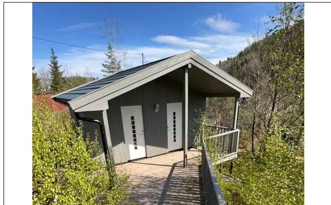
Uthus oppført på eiendommen.
