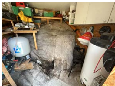
Del av rom under terreng.
