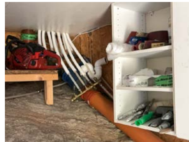
Del av rør til vann.
