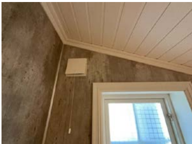
Montert ventil i vegg.
