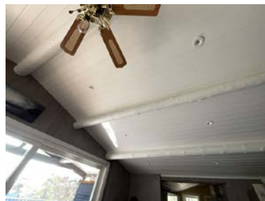
Del av takkonstruksjon.
