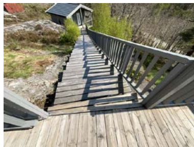
Trapp ned fra terrasse.
