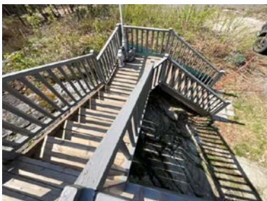
Trapp ned fra terrasse.
