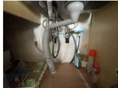
Del av rør til vann.
