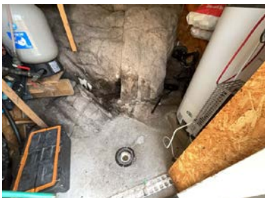
Del av rom under terreng.
