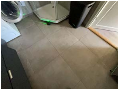
Målt fall på gulv. Del av gulv.
