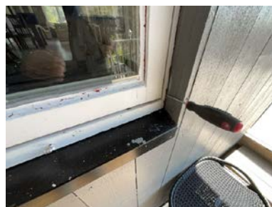
Stikkontroll på vinduer er utført.
