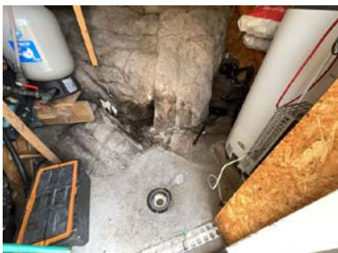
Del av rom under terreng.
