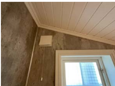
Montert ventil i vegg.
