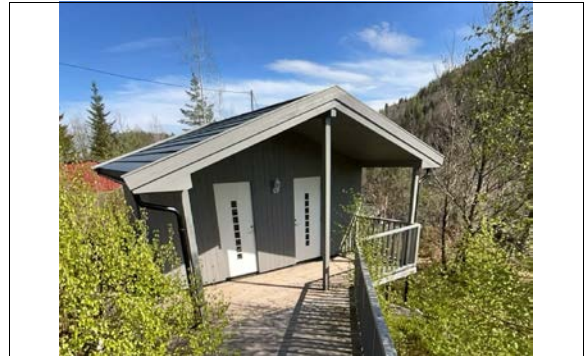
Uthus oppført på eiendommen.
