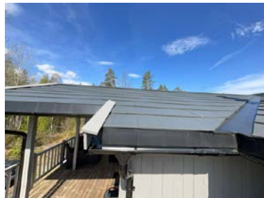
Del av taktekking.
