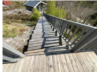
Trapp ned fra terrasse.
