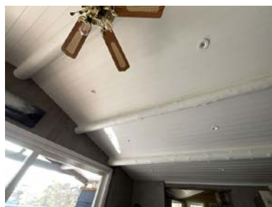
Del av takkonstruksjon.
