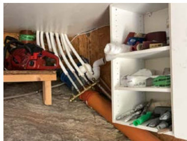
Del av rør til vann.
