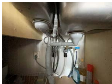
Del av rør til avløp.
