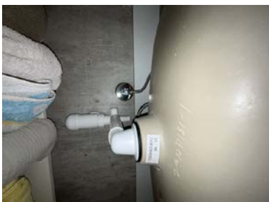
Del av rør til avløp.
