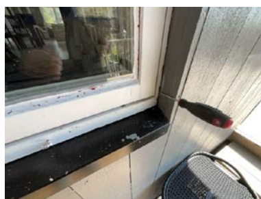
Stikkontroll på vinduer er utført.
