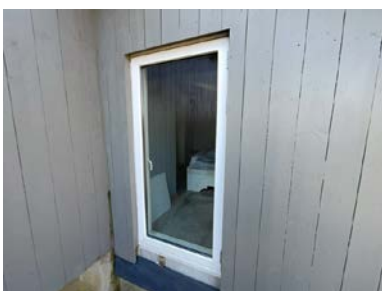
Eksempel på vindu i yttervegg.
