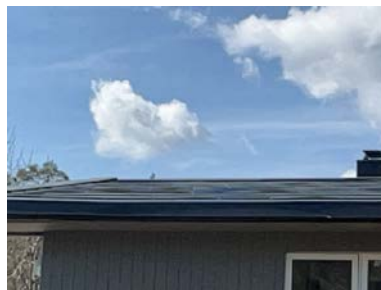
Del av taktekking.
