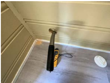
Hull for kontroll av fukt.
