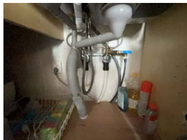
Del av rør til vann.
