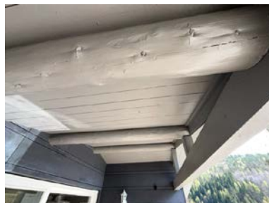
Del av takkonstruksjon.
