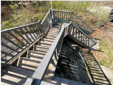
Trapp ned fra terrasse.
