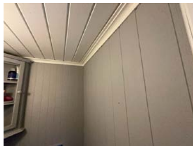
Del av toalettrom.
