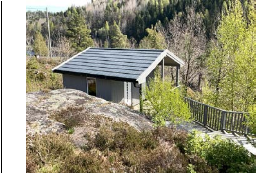
Uthus oppført på eiendommen.
