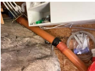
Del av rør til avløp.
