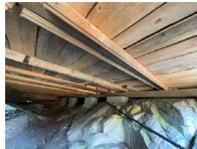
Del av etasjeskille sett fra undersiden.
