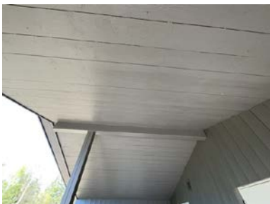
Del av takkonstruksjon.
