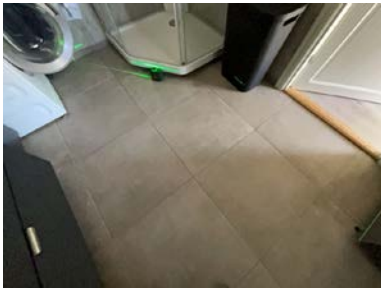
Målt fall på gulv. Del av gulv.
