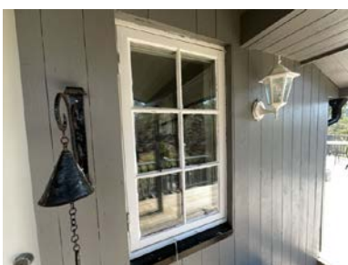
Eksempel på vindu i yttervegg. Eldre dato.
