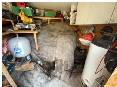
Del av rom under terreng.
