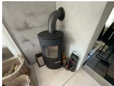
Montert ovn i stue.
