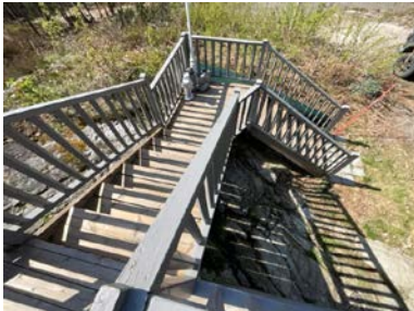
Trapp ned fra terrasse.
