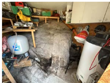
Del av rom under terreng.
