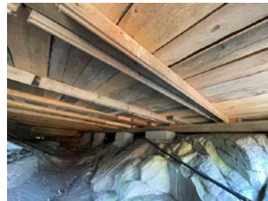
Del av etasjeskille sett fra undersiden.
