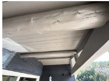
Del av takkonstruksjon.
