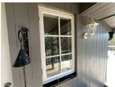
Eksempel på vindu i yttervegg. Eldre dato.
