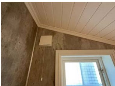
Montert ventil i vegg.
