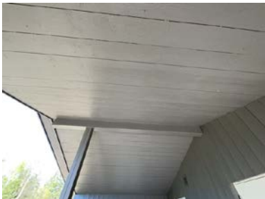
Del av takkonstruksjon.
