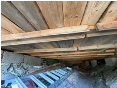
Del av etasjeskille sett fra undersiden.
