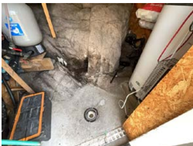
Del av rom under terreng.
