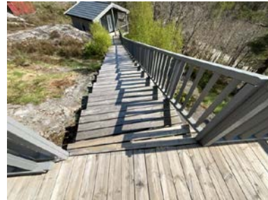
Trapp ned fra terrasse.
