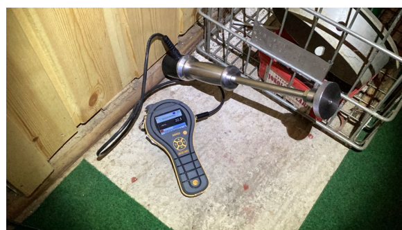
Fuktmåling ble foretatt, jeg målte skadelig fukt.
