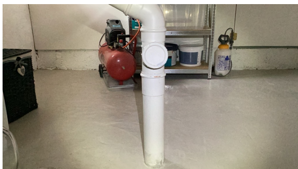
Stakeluke på vaskerom.
