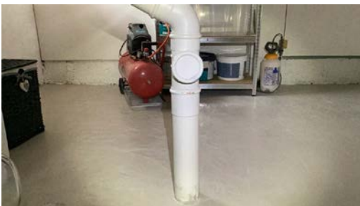
Stakeluke på vaskerom.
