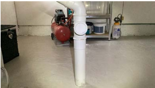
Stakeluke på vaskerom.
