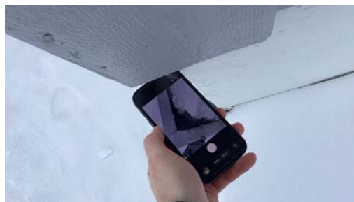
Det er observert åpninger i utvendig komplettering som øker risikoen for at mus kan komme inn.
