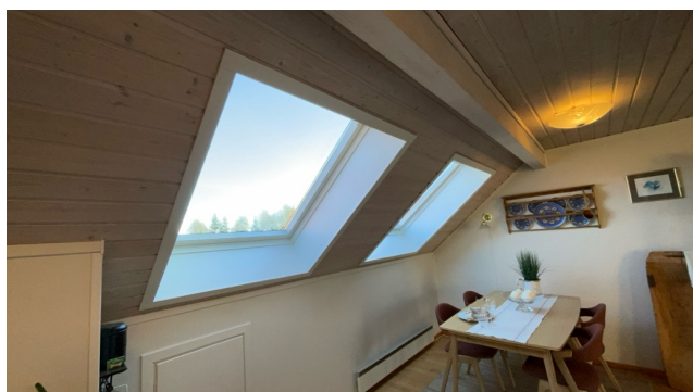
Ingen synlige lekkasjer rundt takvinduer på befaringsdagen.
