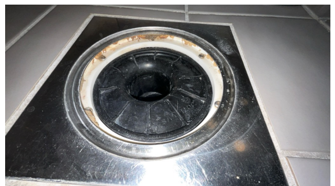
Kontroll av sluk.
