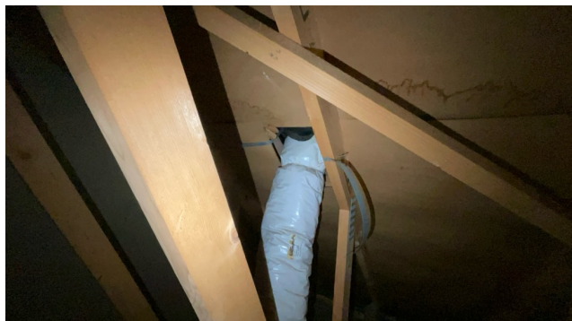
Kontroll rundt rørgjennomføringer.
