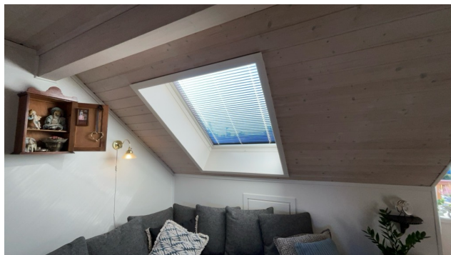
Ingen synlige lekkasjer rundt takvinduer på befaringsdagen.
