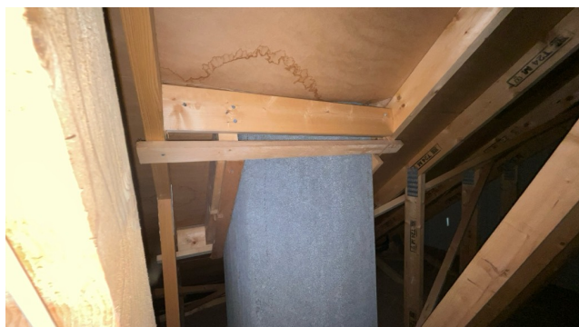
Kontroll rundt pipeløp.
