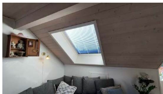
Ingen synlige lekkasjer rundt takvinduer på befaringsdagen.
