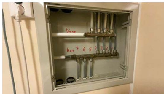
Besiktigelse av røropplegg.
