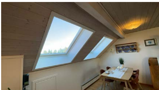
Ingen synlige lekkasjer rundt takvinduer på befaringsdagen.
