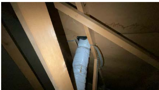
Kontroll rundt rørgjennomføringer.
