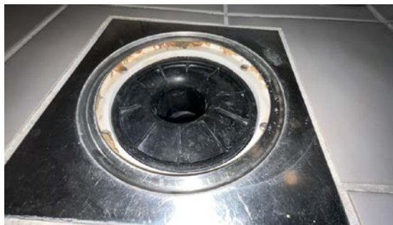
Kontroll av sluk.
