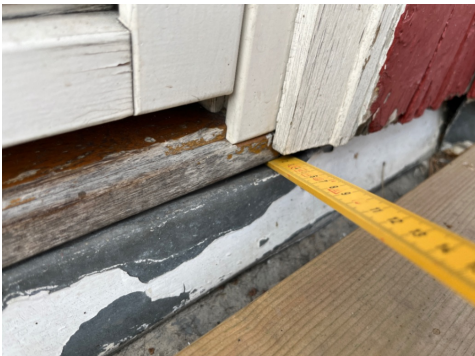
Fall inn mot vegg for beslag balkongdør.
