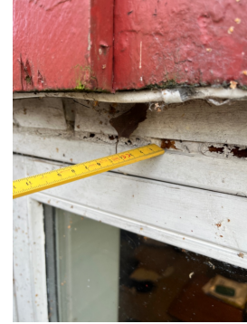
Manglende tetting kjellervindu.
