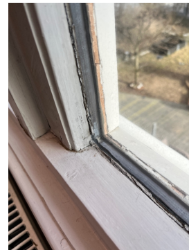
Manglende tetting kjellervindu.
