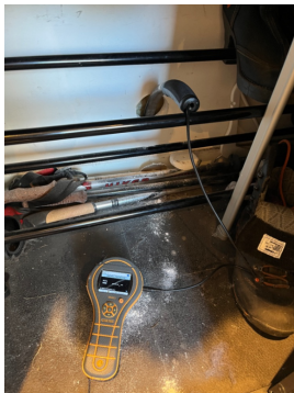
Fuktmåling i vegg mot våtsonen.
