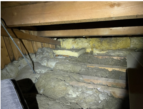
Tettet mot lufting til loft.
