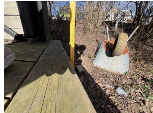
Over 0,5m ned til terreng.
