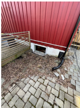
Avslutning av nyere knotteplast mot innkjørsel.
