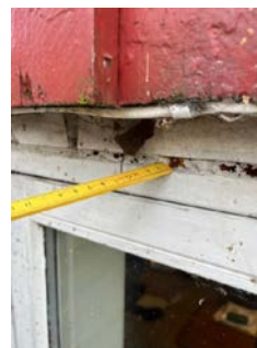
Manglende tetting kjellervindu.
