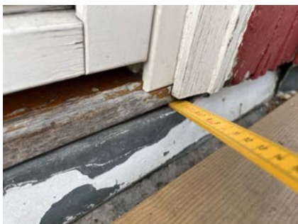
Fall inn mot vegg for beslag balkongdør.
