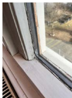
Manglende tetting kjellervindu.
