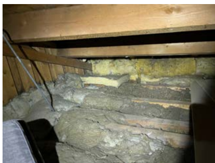
Tettet mot lufting til loft.
