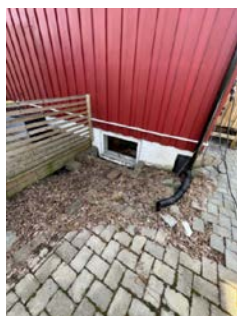
Avslutning av nyere knotteplast mot innkjørsel.
