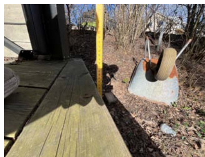
Over 0,5m ned til terreng.
