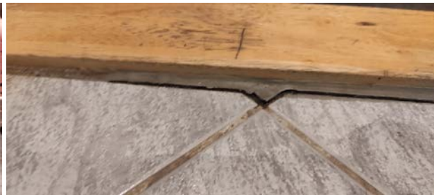
Kontroll av fall mot sluk.
