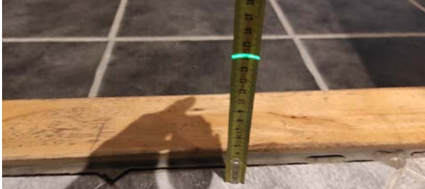
Kontroll av fall mot sluk.
