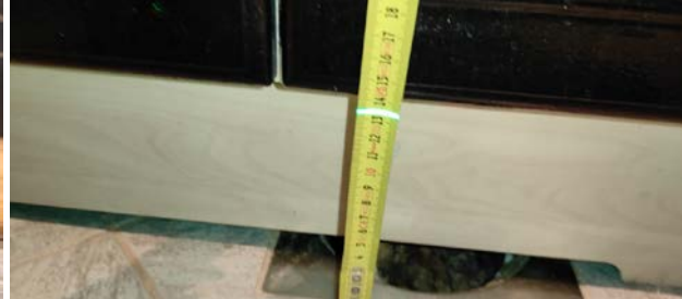
Kontroll av fall mot sluk.
