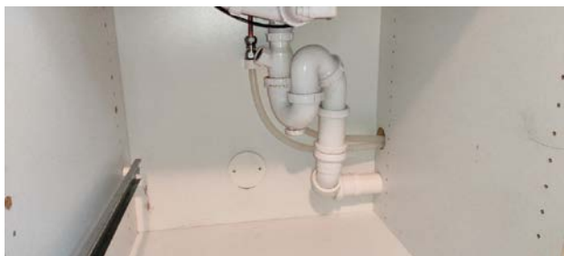
Kontroll av røropplegg.
