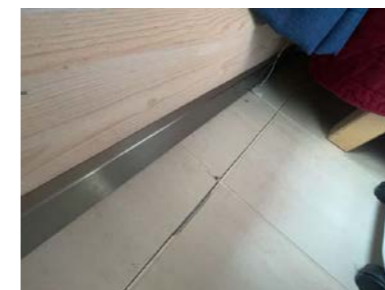
Soverom under vindu
