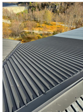
Nye stålplater langs sløysrenne
