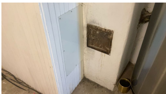
Sotluke i kjeller
